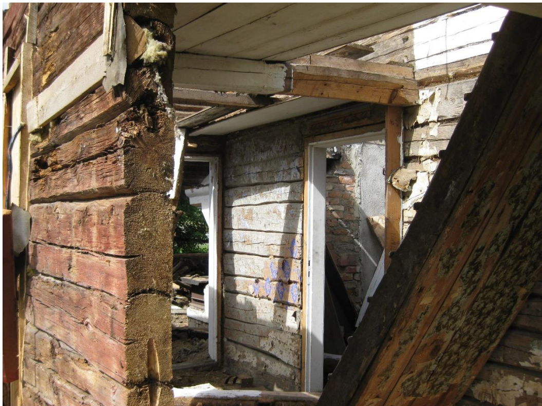
Övervåningen borta med trappan kvar.
