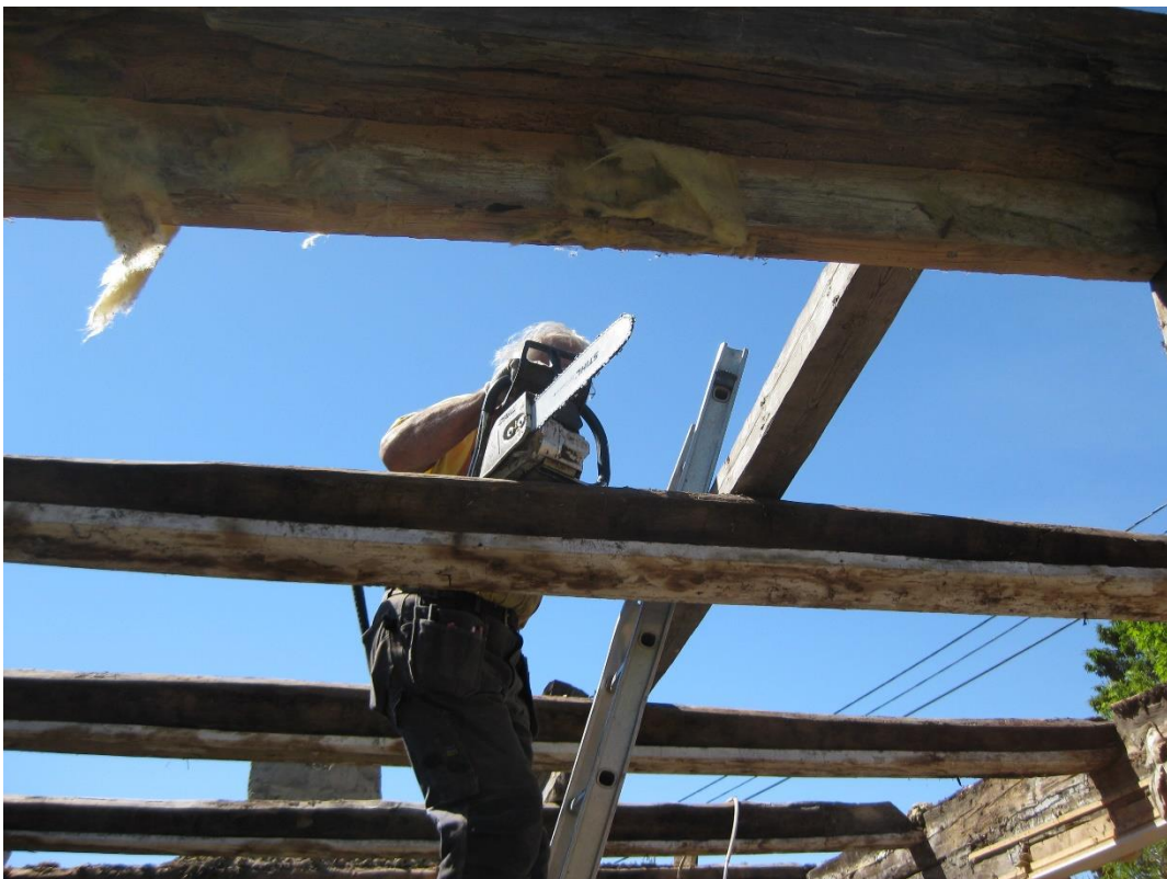
Det sista av innertaket togs bort.
