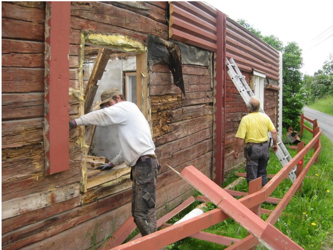
Fönsterbågar och resterande panel avlägsnas.
