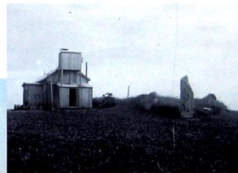
Under 1940-talet placerade militären ut en byggnad för flygbvakning intill skeppssättningen och ett skyddsrums grävdes ned mellan två stenar. Det strategiska och höga läget på Kåsehuvud har även inneburit att Ales stenar fungerat som ett landmärke för sjöfarten. Stenarna finns utmärkta på Gerhard Buhrmans kuskarta från år 1684. Foto: ATA/Karl Alfred Gustavsson, 1942.
